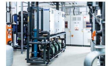
Die modulare Kälteanlage Eco2Middle
